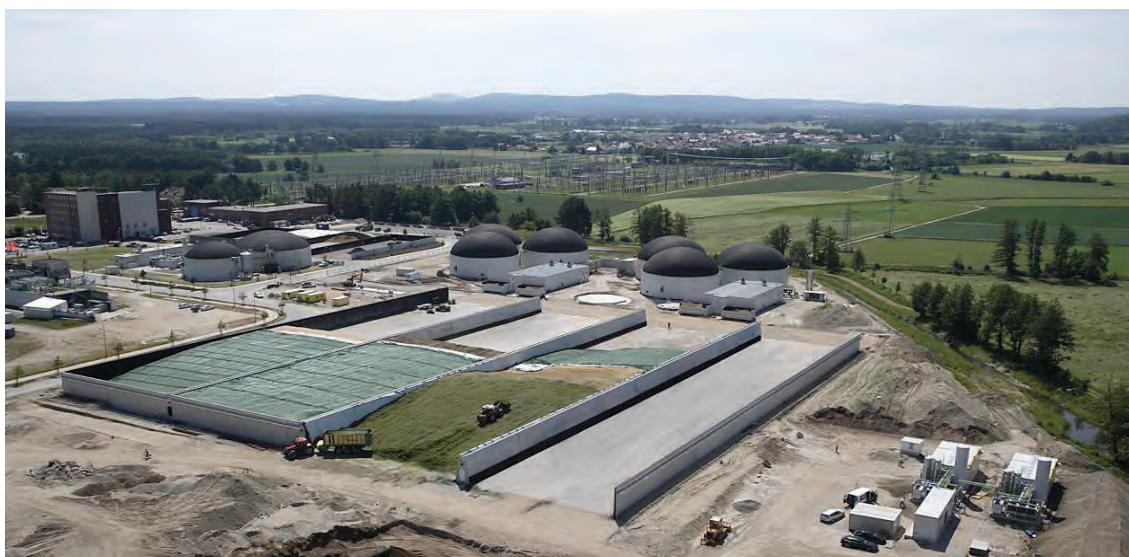
Abbildung: Bioerdgasanlage Schwandorf Quelle: Schmack Biogas AG
